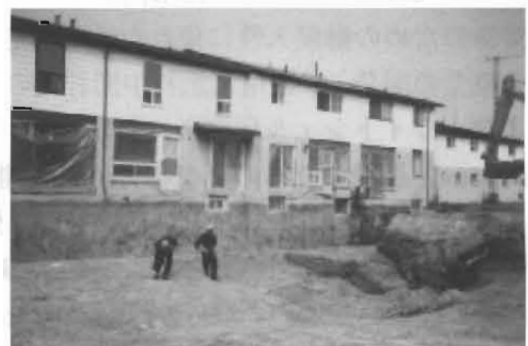
図3 マルベリンでの汚染土壌作業（オンタリオ州、トロント）
