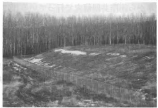
図4 アルバータ州フォートマクマレーでのLLW廃棄物貯蔵セル
