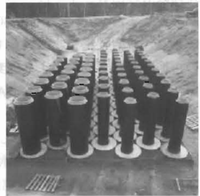
図2 建設中の高いレベルの放射性廃棄物貯蔵用スタンドパイプ
